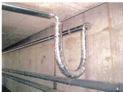
Giunto flessibile per il collegamento dell'impianto idrico dell'edificio all'acquedotto cittadino
